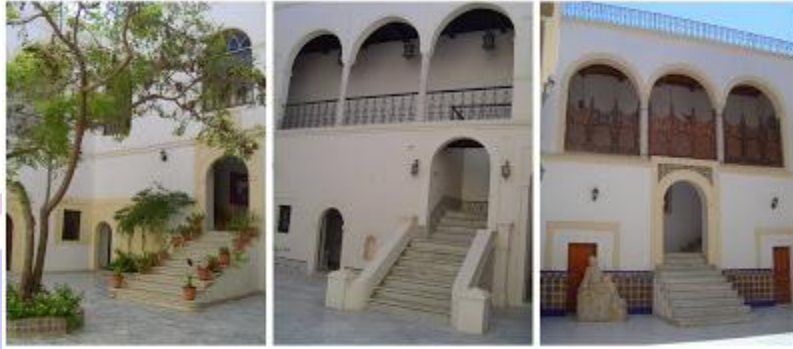
شكل رقم (a-9) بعض مباني المدينة القديمة بعد الترميم
